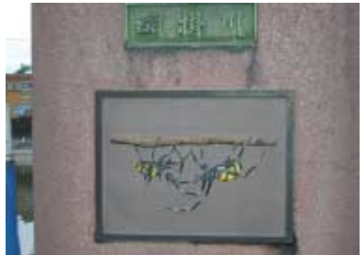
網掛橋の欄干
